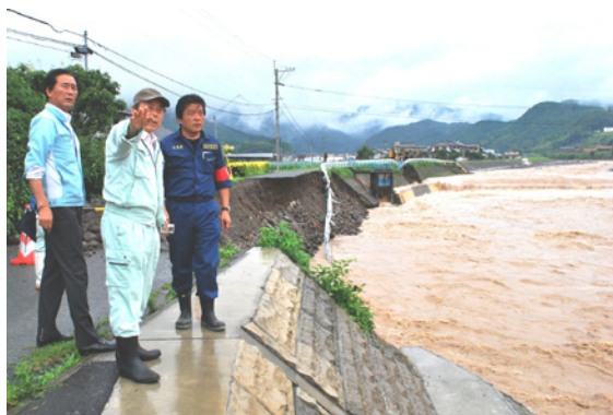
▲花月川の護岸崩落現場を調査する仁比参議院議員（右端）ら＝6日、大分県日田市
